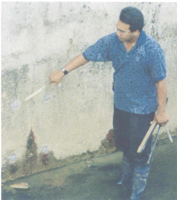
PVC Bio Trap dimasukkan kedalam lubang weep hole menggunakan "Rubber Hammer
