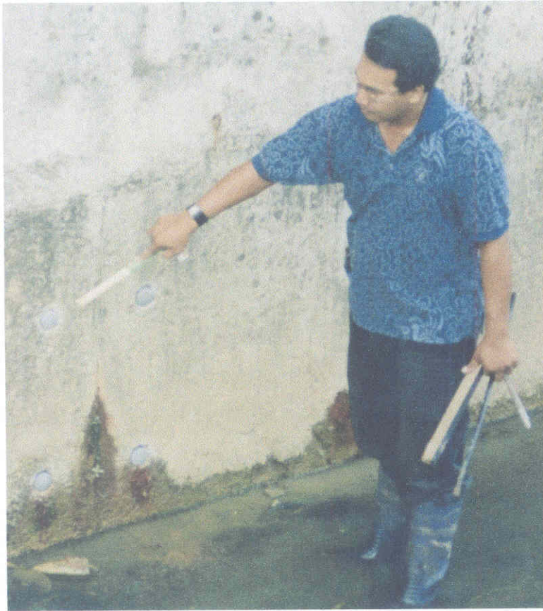
Kedudukan PVC Bio Trap yang telah siap dipasang
