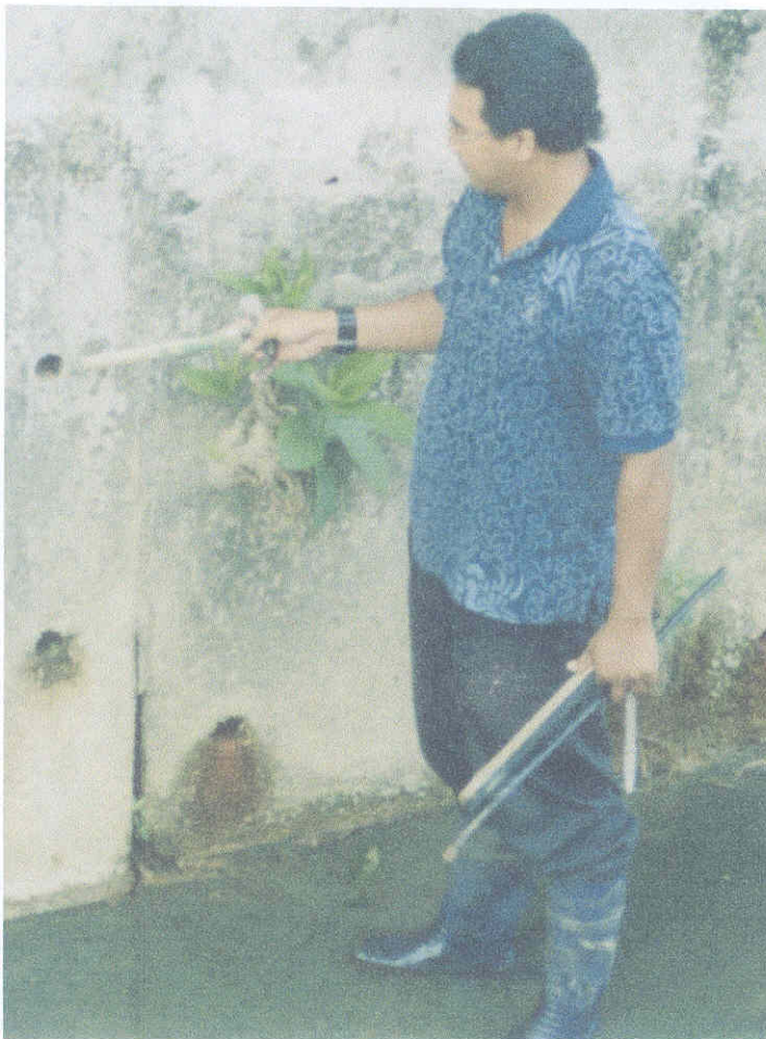
Weep hole yang telah dibersihkan
